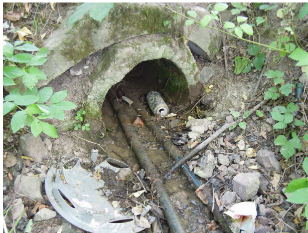
Porušený propustek v téže části silnice v km 7,212
