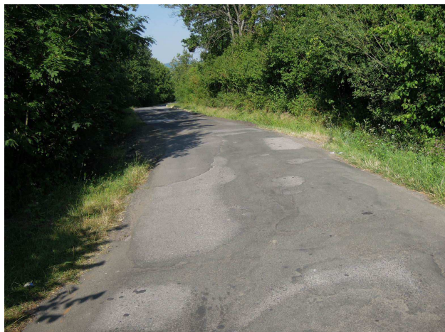
Silně porušená silnice s poklesem vozovky v km cca 7,200
